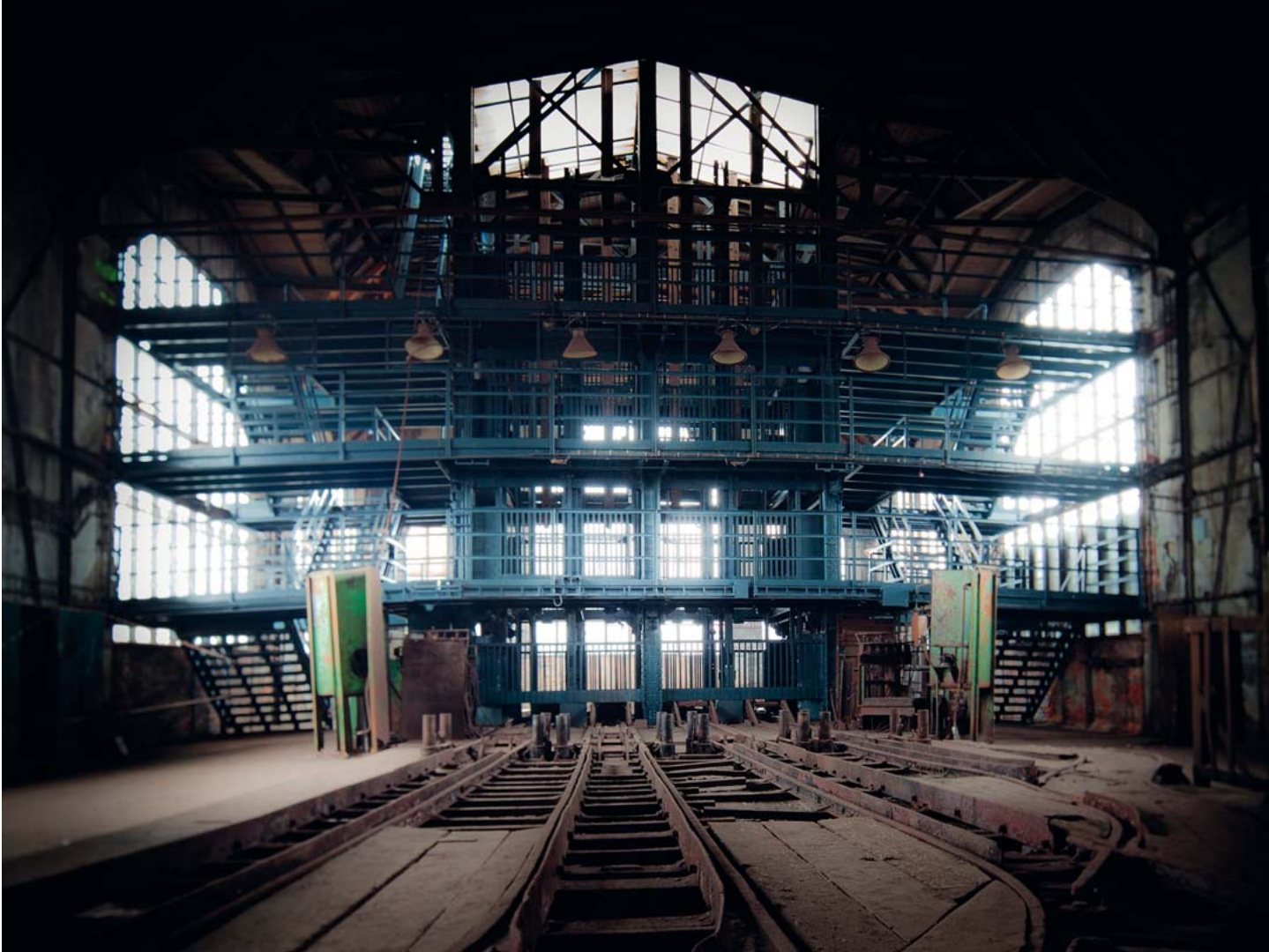
Interiér těžní budovy
