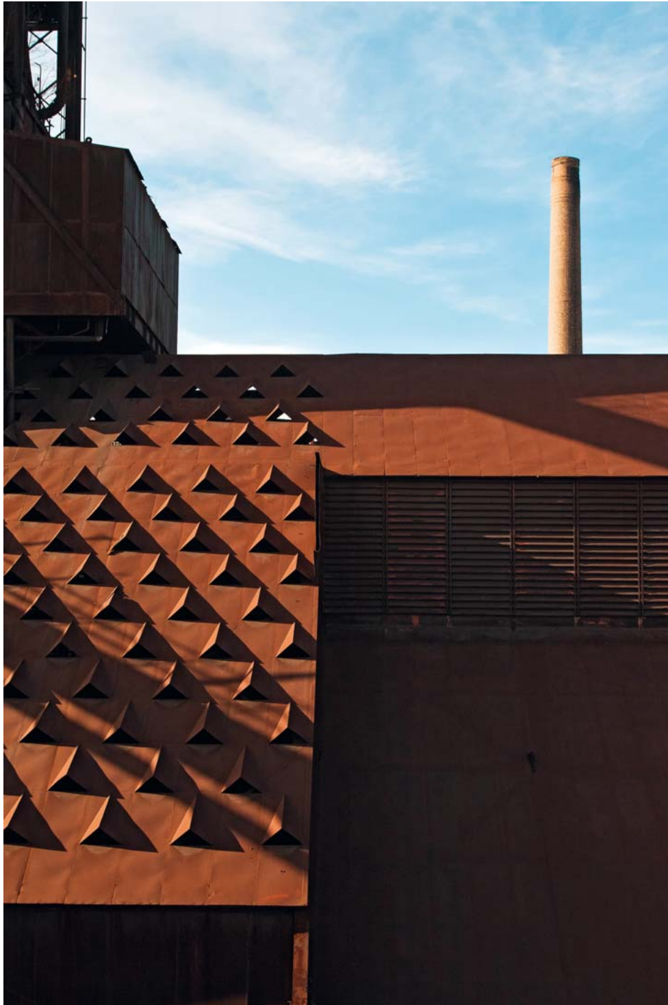
Detail střechy provozní budovy v areálu Vysoké pece č. 1
