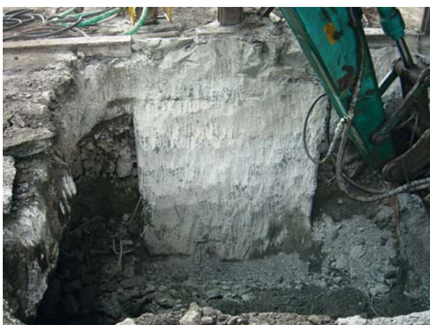
Bourání betonu v dojezdu skipu
