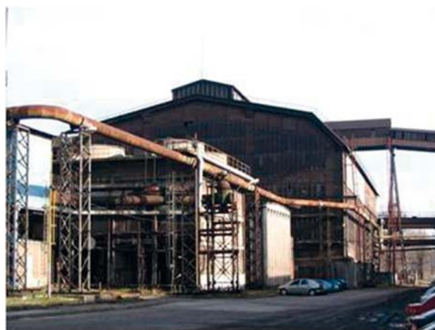
VI. energetická ústředna před rekonstrukcí
