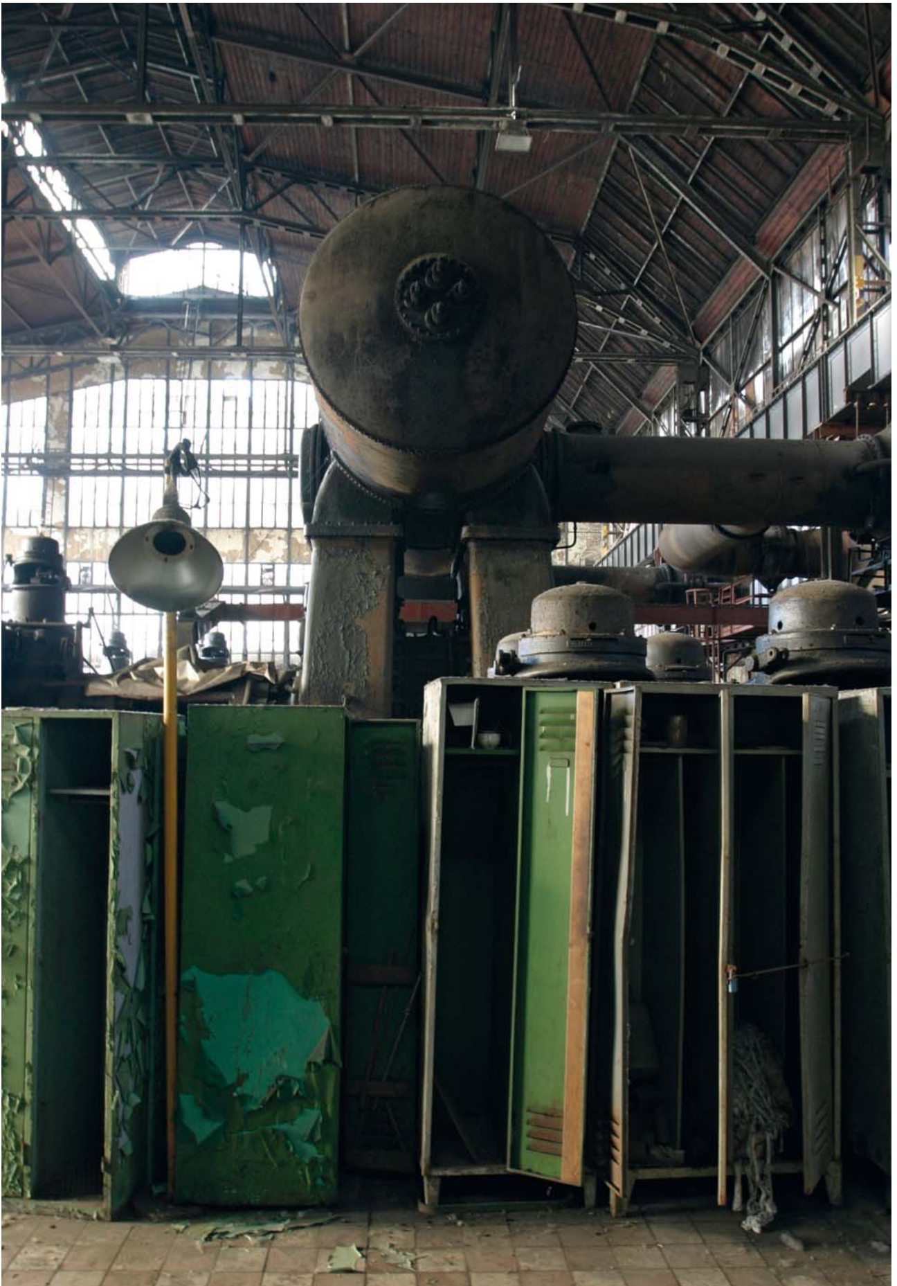
Interiér VI. energetickej ústredny
