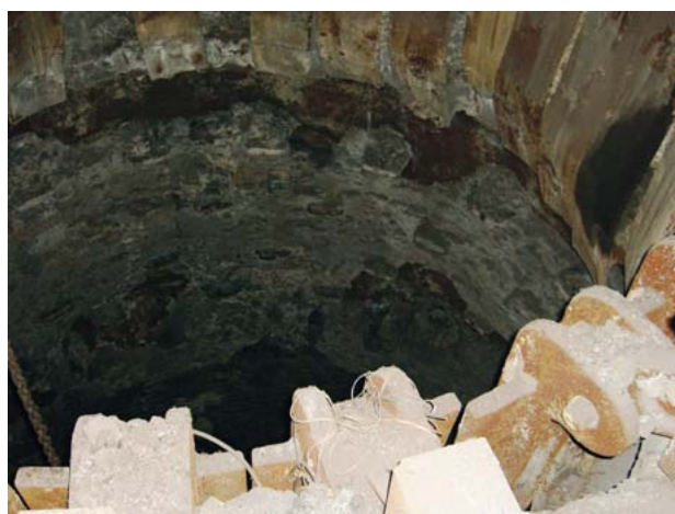
Nesoudržné vrstvy vyzdívký a ochranné pancíře
